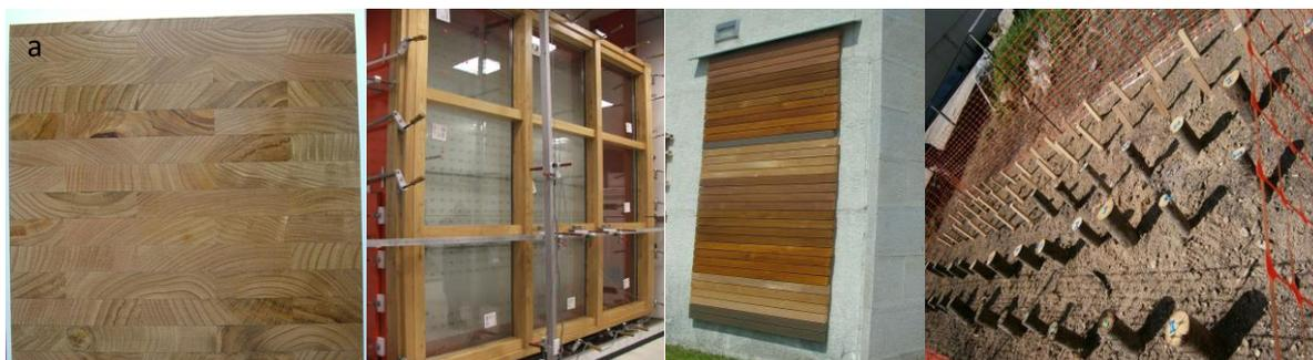
Figura 2. Prototipos construidos por Exfopino a. Loseta maciza. b. Muro cortina. c. Fachada trasventilada. d Campo de estacas
