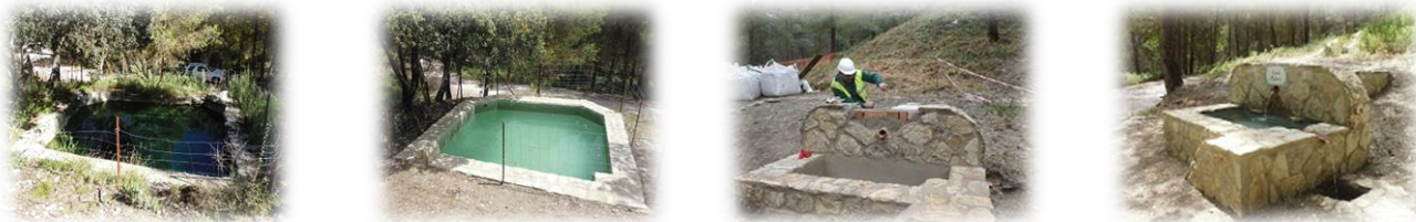
Figura 6. Fotografías del estado de la fuente antes y después de la intervención y propias de la actuación.
