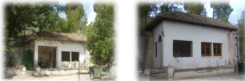
Figura 2. Fotografías de la fase de rehabilitación de una de las edificaciones.
