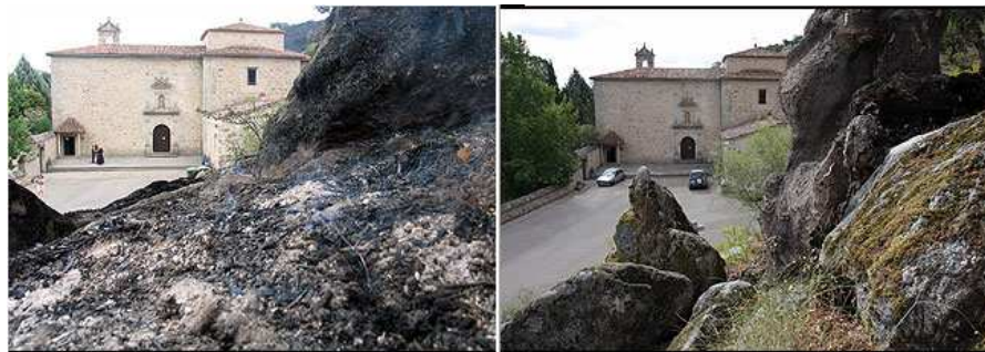
Convento del Palancar y Berrocal, tras el incendio y en la actualidad
