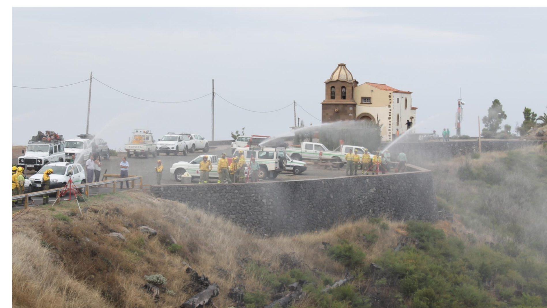
Figura 6. Alternativas técnicas planteadas. Uso del sistema SIDEINFO para la creación de cortafuegos húmedos en zonas estratégicas. Fuente: MEDI XXI GSA, 2016.
