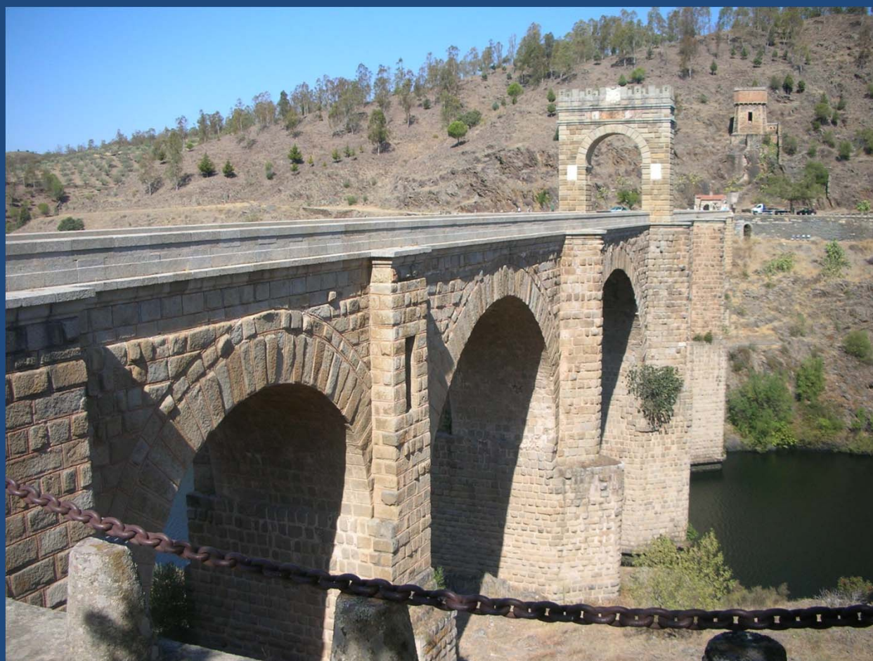
Puente de Alcántara sobre el río Tajo
