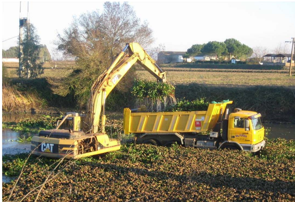
Equipo medios mecánicos: Retroexcavadora (ruedas o cadenas) con cazo adaptado y camión doble carro
